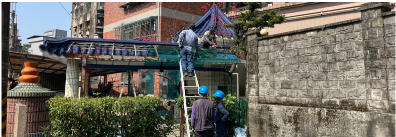
柒伍宮遮雨棚更換修繕
