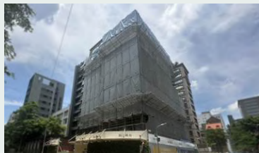
隔音帆布設置
